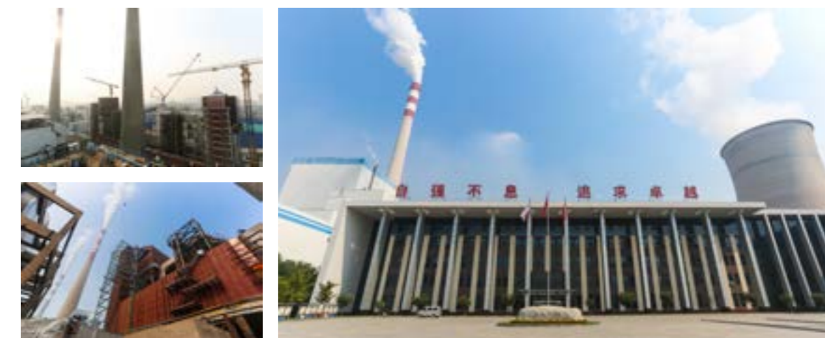
· 大唐三门峡 3 号、4 号 (2x630MW) 机组烟气超低排放脱硫、除尘改造工程项目
